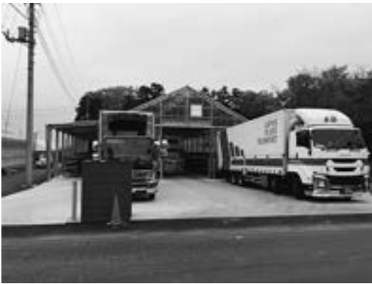
写真4 新設した出荷場
